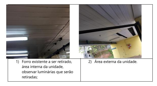
3.1 Fornecimento e instalação de forro de PVC em perfil U frisado duplo 10 de 8mm na cor branca, estruturado em perfil metalon de aço galvanizado tipo metalon, fixado com parafuso de aço gn 13, acabamento tipo U;
